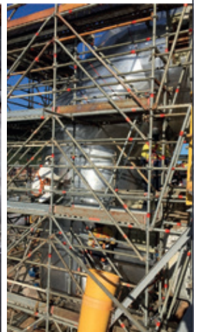
Pose de calorifuge sur tuyauterie de DN 4000
