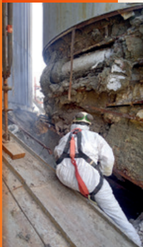
Recherche de fuite
